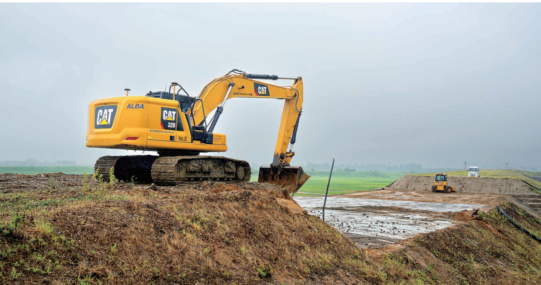
国道49阿賀野バイパスの盛土整形を3Dマシンコントロールで行う次世代油圧ショベル320。現場のすぐ下では遺跡の発掘調査も行われていました。
