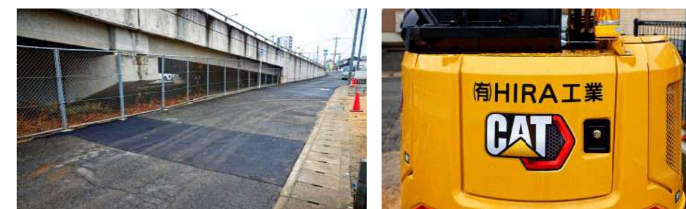
写真上：社長の平松様。現場で乗ることはなくなったそうですが、建設機械にはこだわりをお持ちです。 写真下左：道路を掘り起こした現場(写真左)を、その日のうちに戻すスピードも管工事では要求されます。 写真下右：購入して間もないCat 303 SR。
