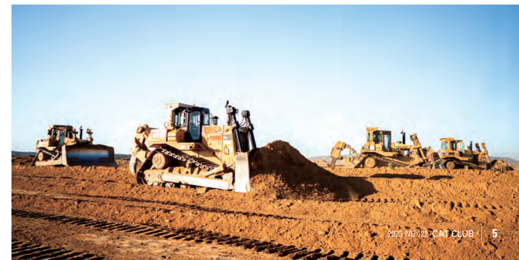
サウジアラビア北西部の砂地に大量投入された大型のCatブルドーザ。
