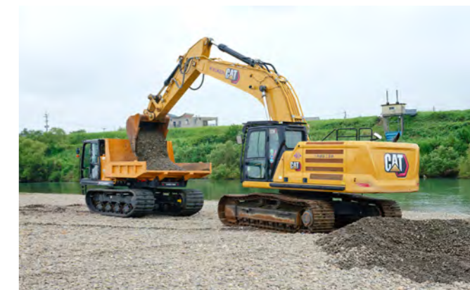
大淀川と本庄川の合流点に近い河道掘削現場での作業。国土強靱化計画の一環で、掘削除去された土砂は、浸食された砂浜海岸への養浜材として利用されています。
