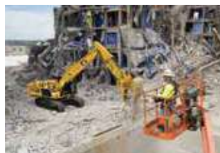
倒壊落石作業
