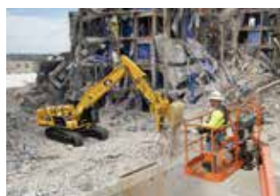
倒壊落石作業
